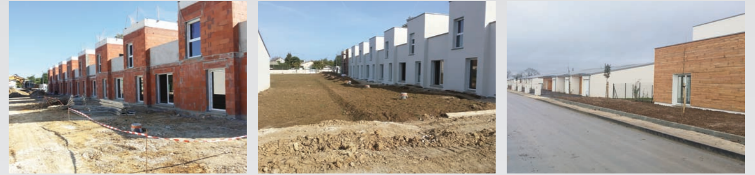
24 logements individuels en RDC et R+1
